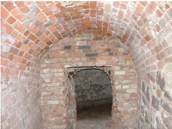
Abb. 17: Durchbruch zum „Alten Gewölbe“ vom Raum 9 aus
