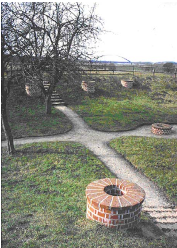
Abb. 11: Lüftungsschächte in der Bastion „Greif“
