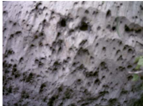
Abb. 3: Deutlich ist die Hauptwindrichtung und der Abschleiß von rechts oben nach links unten zu sehen. Ausschnittgröße 20 x 15 cm
