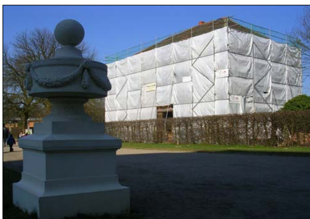
Abb. 1: Eingerüstetes Fontänenhaus im April 05, alle Fotos: U. Jueg, Ludwigslust
