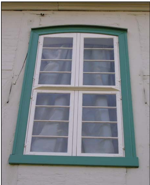
Abb. 15: Originalfenster mit zwei originalen Scheiben
