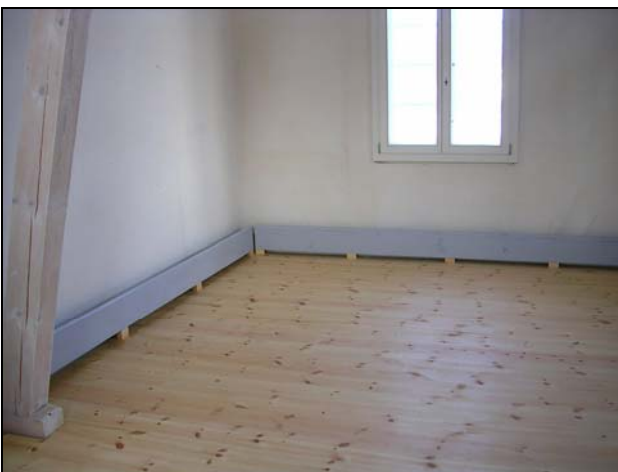
Abb. 22: neue Fußbodendielung mit Verkleidung der Lamellenheizkörper
