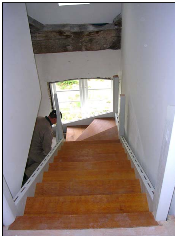
Abb. 18: Einbau der neuen Treppe im September 2005
