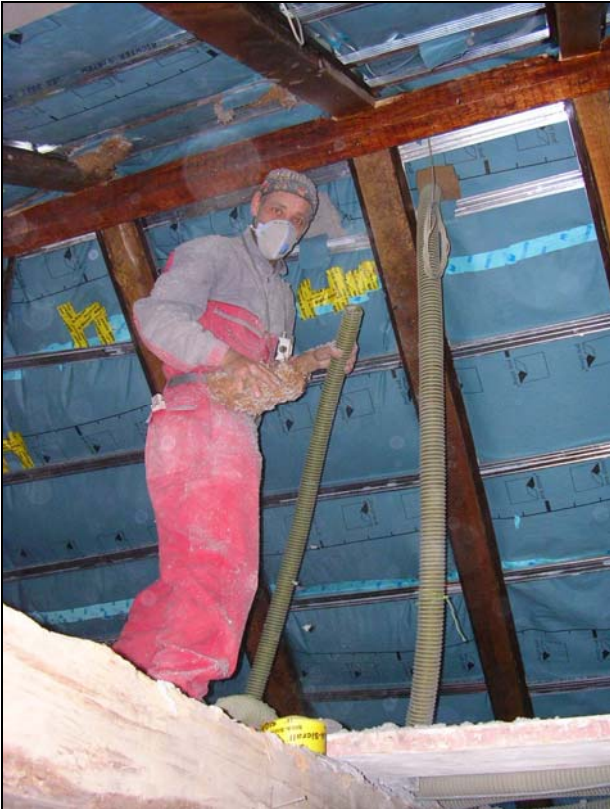
Abb. 21: Einbringen der Isolierung im Seminarraum im August 2005
