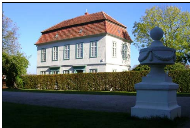
Abb. 2: Sanierte Außenfassade im November 2005,
