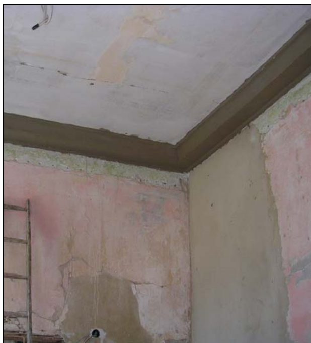
Abb. 3: Alte Stuckelemente traten bei der Entkernung hervor.
