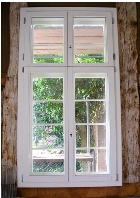
Abb. 16: Neu gefertigte Fenster
