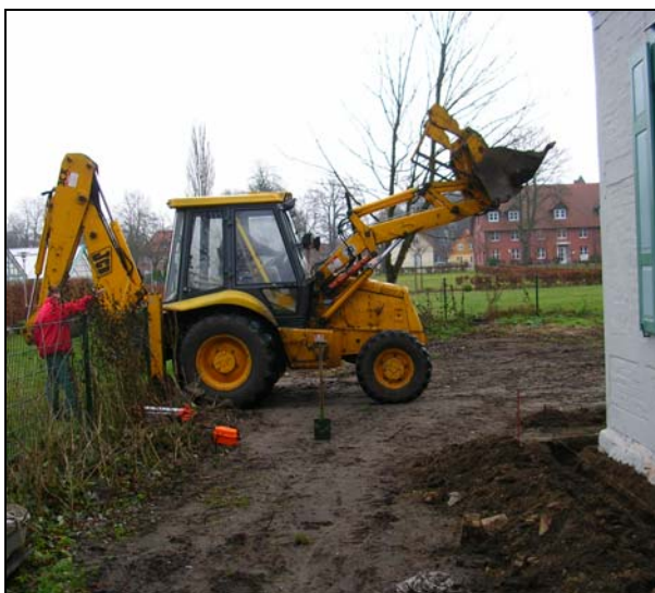
Abb. 25: Beginn mit den Arbeiten zur Pflasterung
