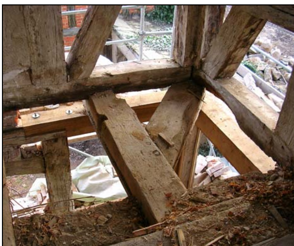
Abb. 9: Erneuerung der Balken im Obergeschoss
