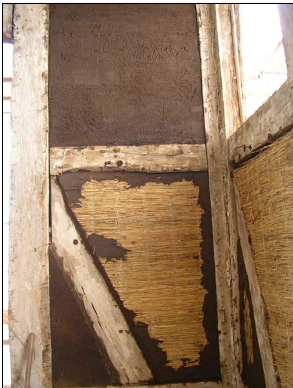
Abb.11: Teilweise verputzte Wand mit Lehmputz
