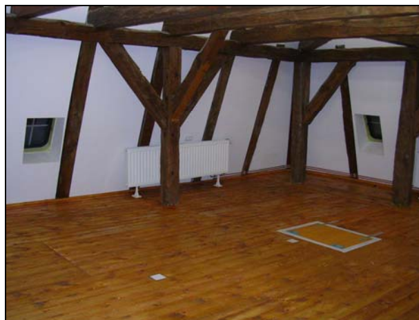
Abb. 14: Dachgeschoss nach der Sanierung, Blick nach Nordwest, Januar 2006
