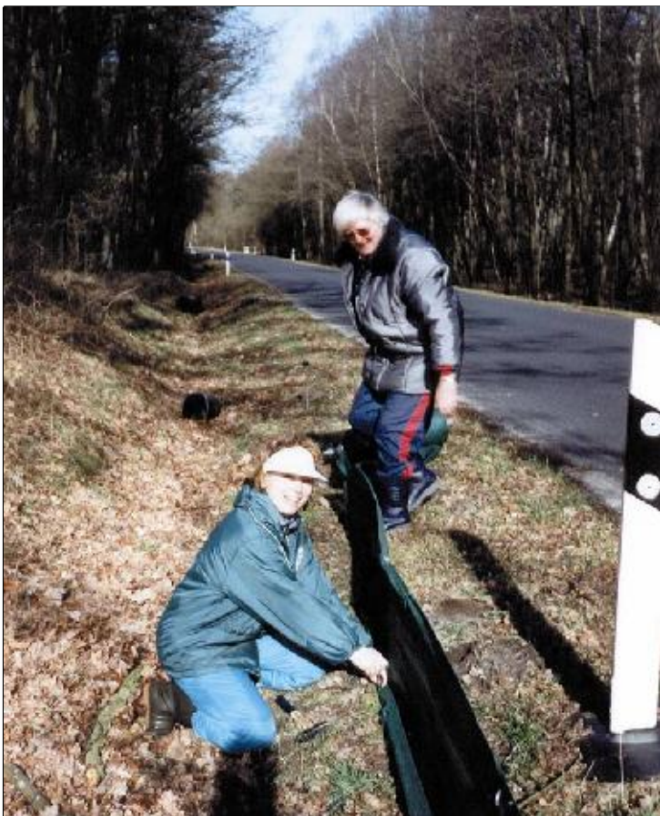
Abb. 1: Aufbau des Schutzzaunes
