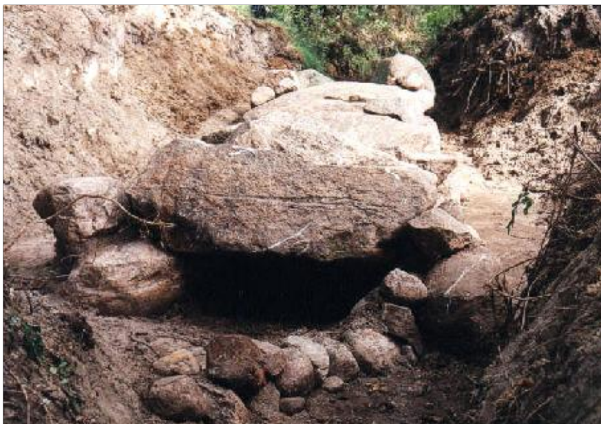
Anlage: Grabungsfoto Steinbrücke Gemarkung „Bollbrüggen“ (geöffnet)
