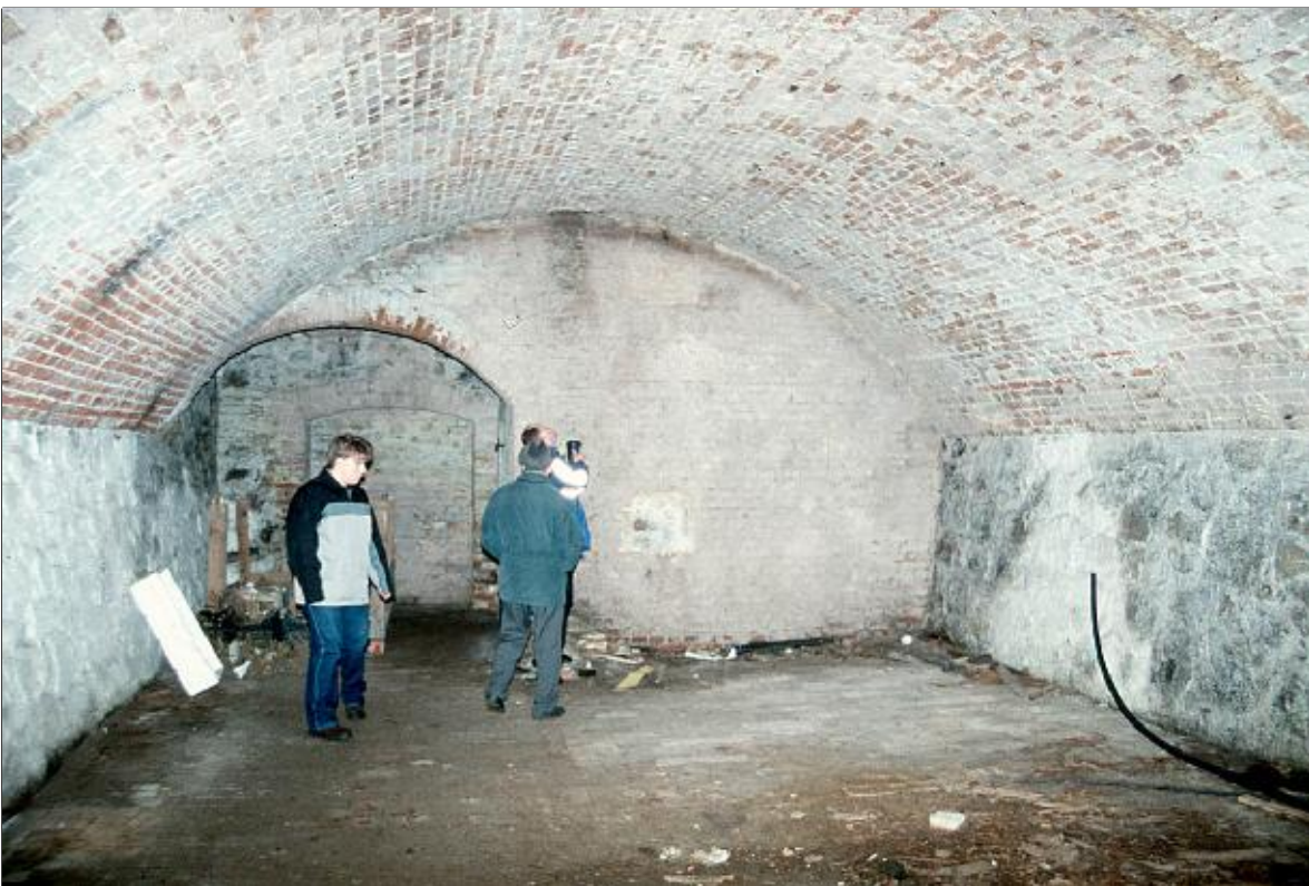
Foto 3: Tonnengewölbe im Raum 2
