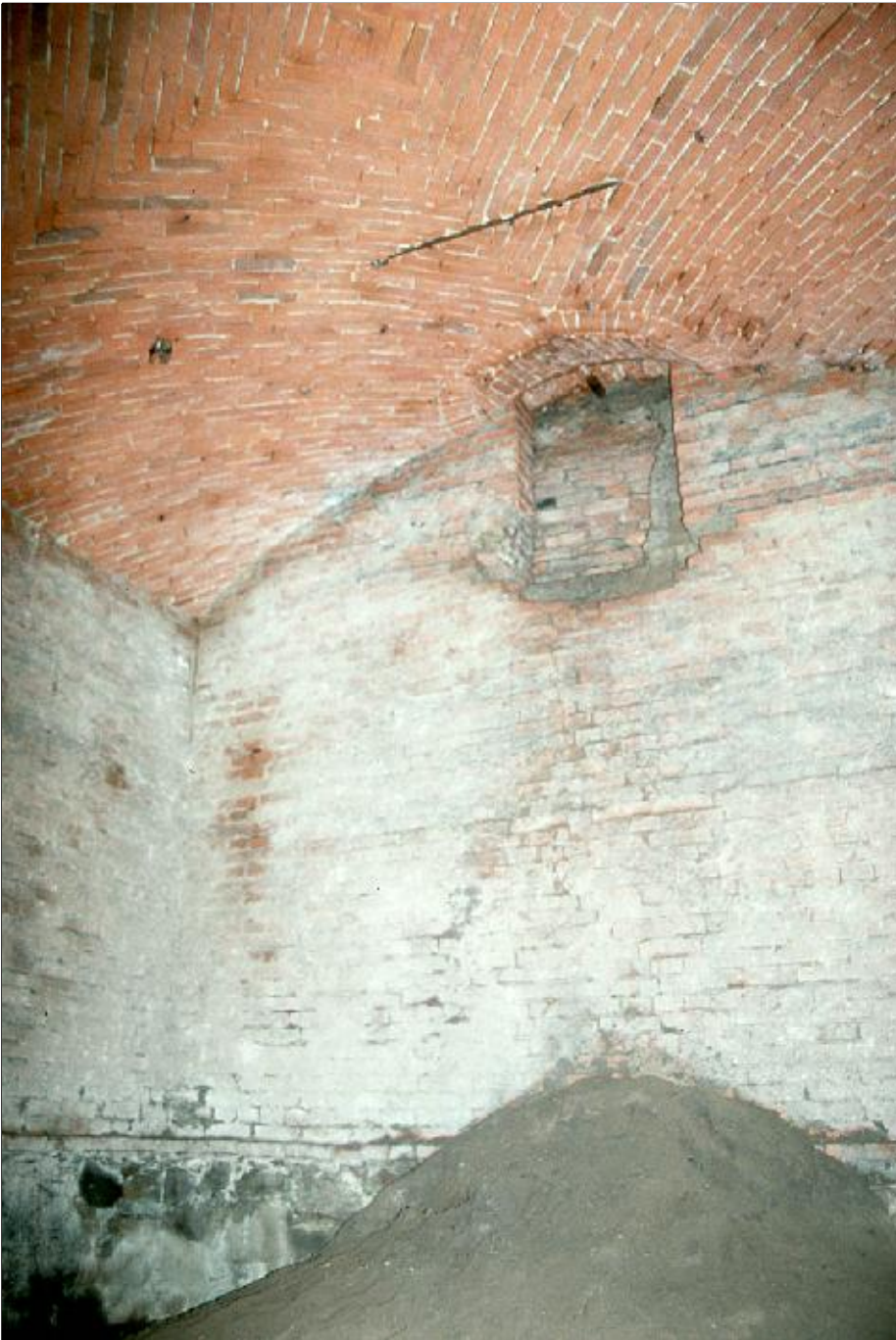
Foto 4: Raum 4 mit Kuppelgewölbe
